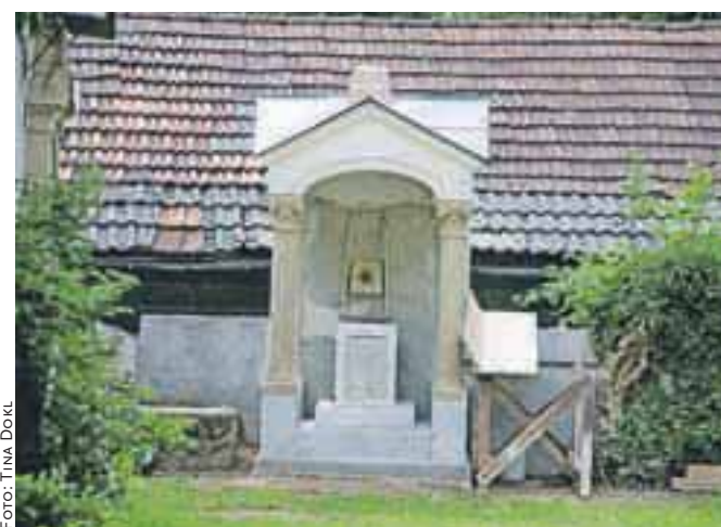
Na pokopališču obnavljajo grobnico rodbine Urbančič.
